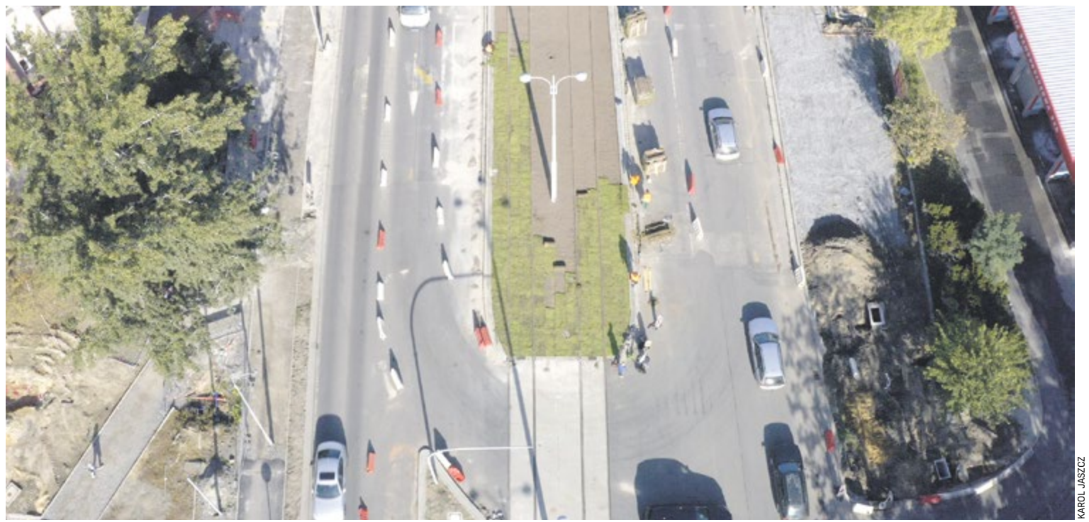
Zielone maty zostały już rozwinięte wzdłuż ulic Popowickiej i Starogrobłowej. Tej niecodziennej sytuacji przyjrzało się oko kamery Wrocław TV
