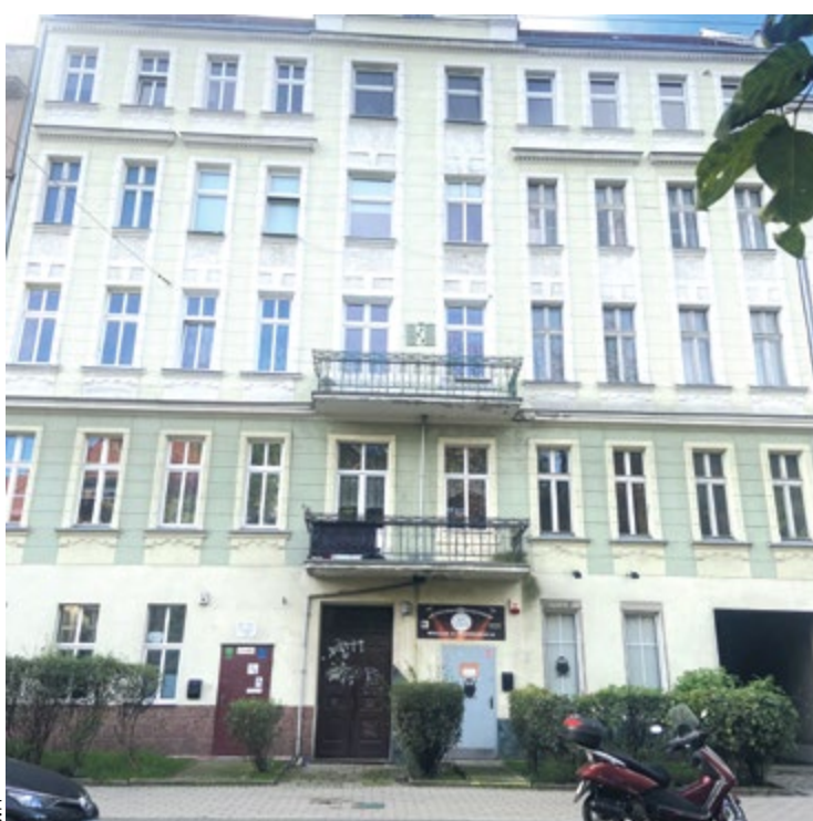
W budynku przy ul. Kraszewskiego 26 wymienione zostaną też okna
