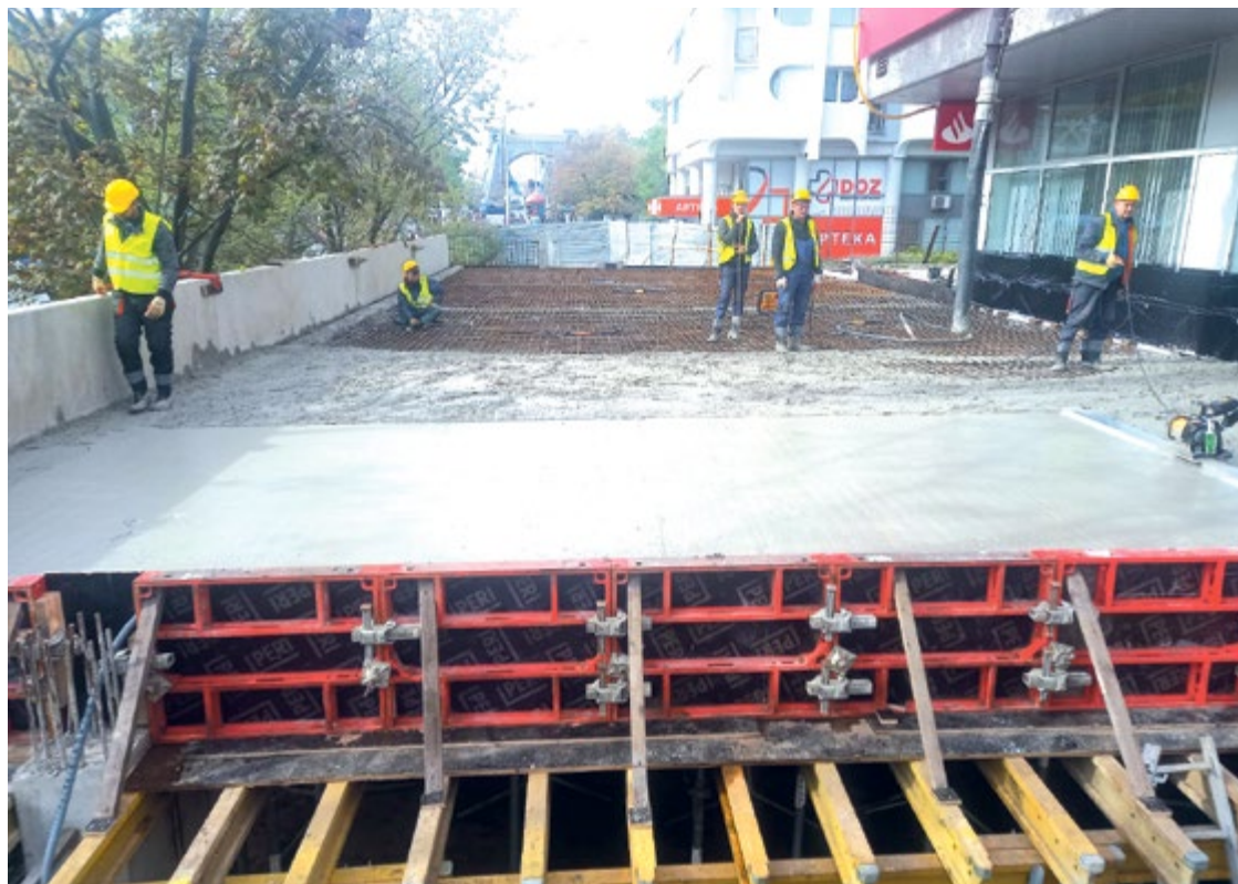
Prace przy odbudowie esplanady na pl. Grunwaldzkim ruszyły pełną parą, trwa betonowanie konstrukcji
